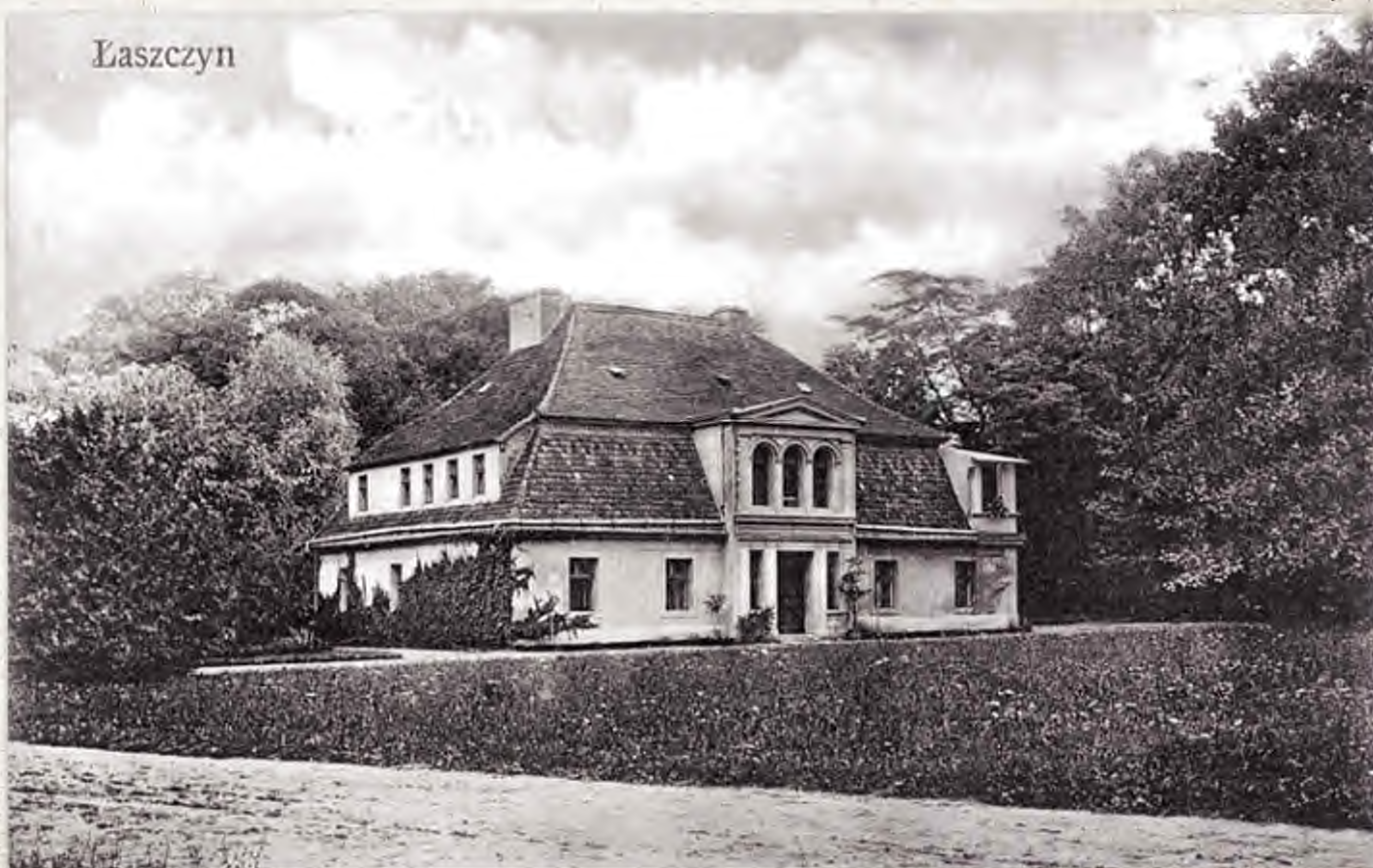
Dworek Szczanieckich w Łaszczynie, 1911 r., widok sprzed przebudowy
